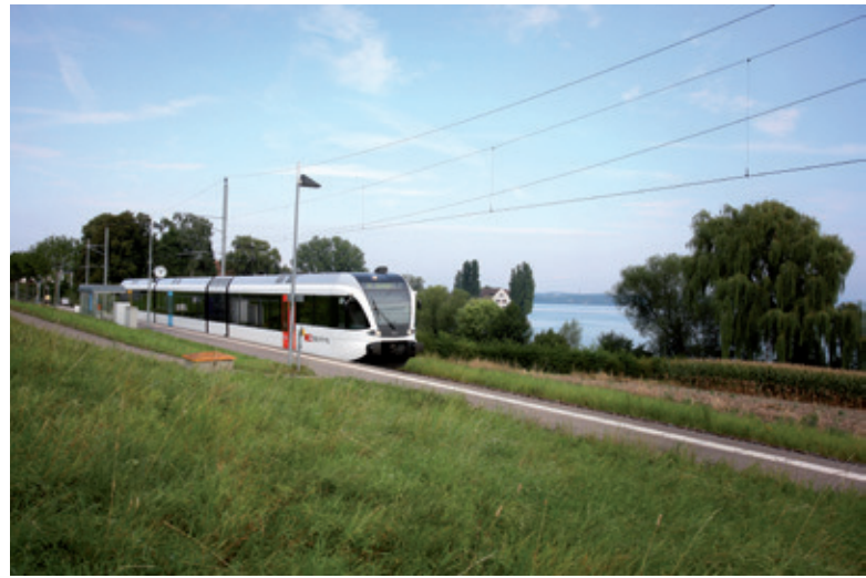
Eingleisige Strecke mit elektrischen Triebwagen (Schweiz: Seelinie bei Münsterlingen)
